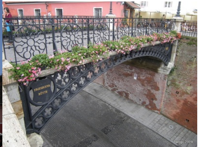
Die „Lügenbrücke“ in Hermannstadt
