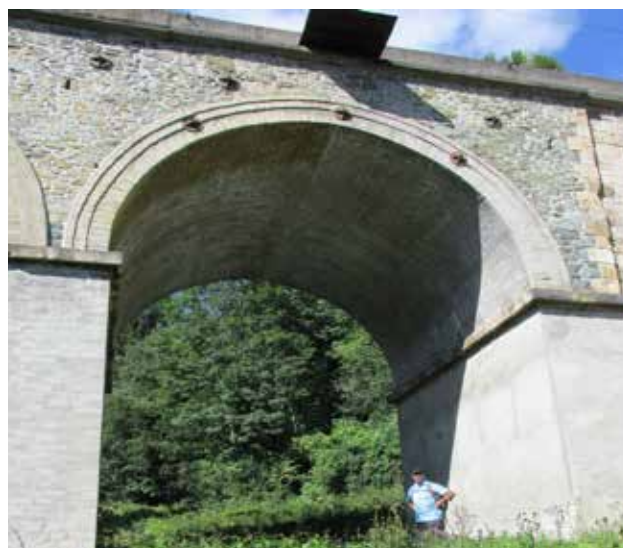
Beim Aufstieg aus den Adlitzgräben zum Pollerwirt am Kreuzberg durchquert man dieses beeindruckende Bauwerk – das Rimpler Viadukt der Semmeringbahn – eine technische Meisterleistung der Bahningenieure um Carl Ritter von Ghega
