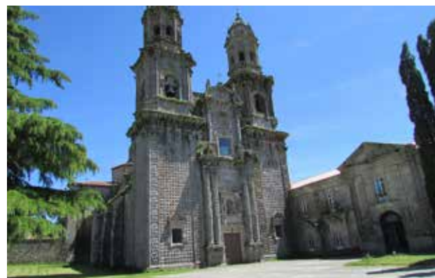
Das ehrwürdige Zisterzienserkloster Sobrado dos Monxes
