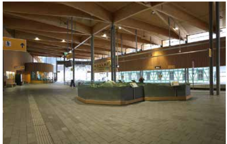
Innenansicht Betriebszentrum Laubenbachmühle, durch Fördermittel des Landes NÖ vor wenigen Jahren hochmodern errichtet
